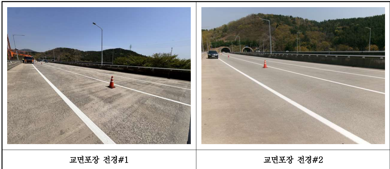
【사진 27.3.20】 교면포장 전경
