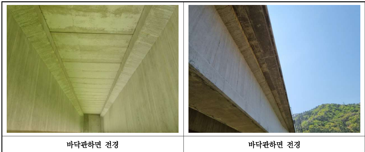
【사진 27.3.2】 바닥판하면 전경
