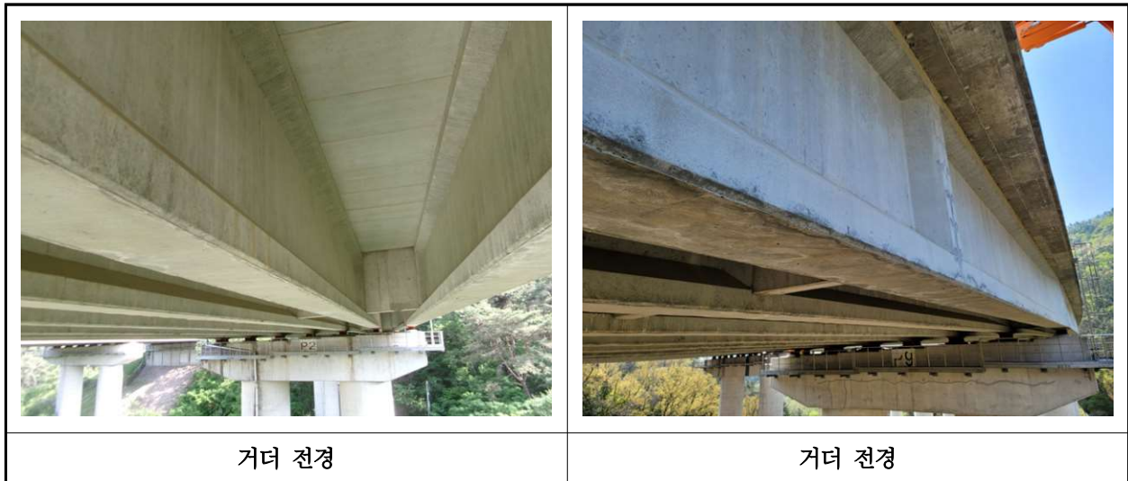
【사진 27.3.4】 거더 전경
