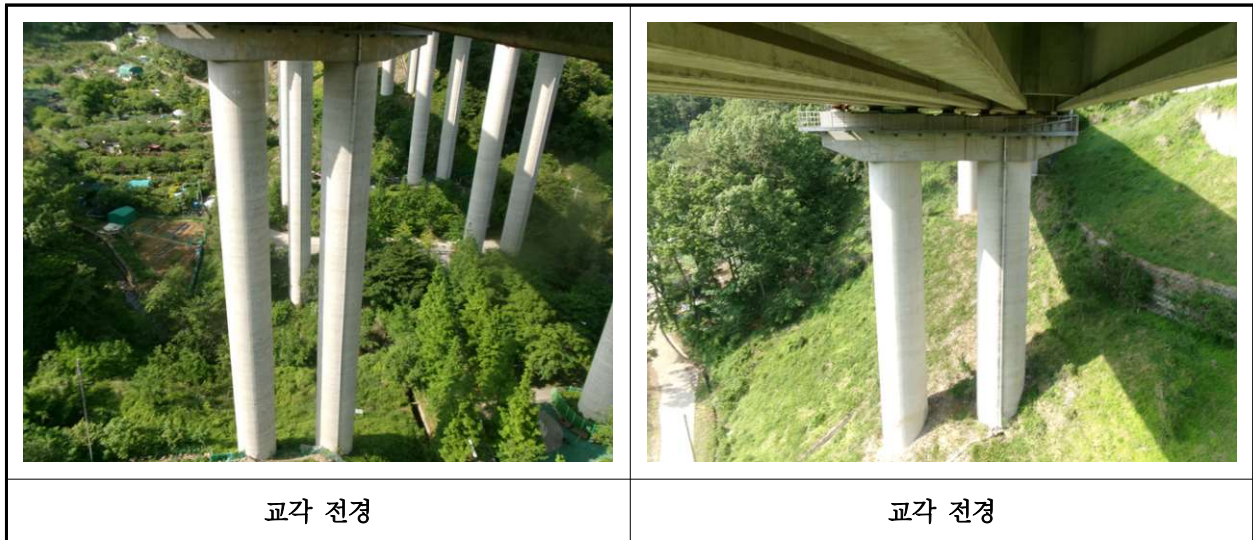
【사진 27.3.10】 교각 전경
