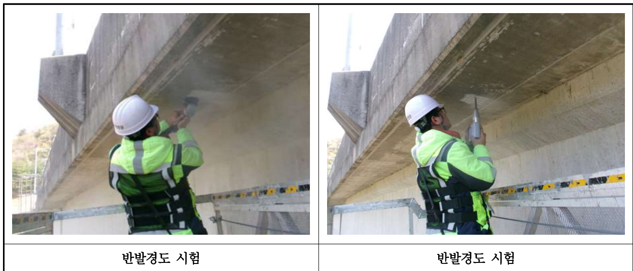
【사진 27.4.2】 반발경도시험 현장사진
