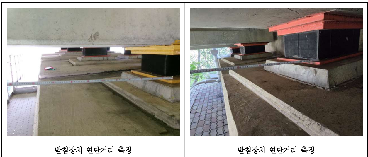
【사진 27.3.15】 교량받침장치 연단거리측정
