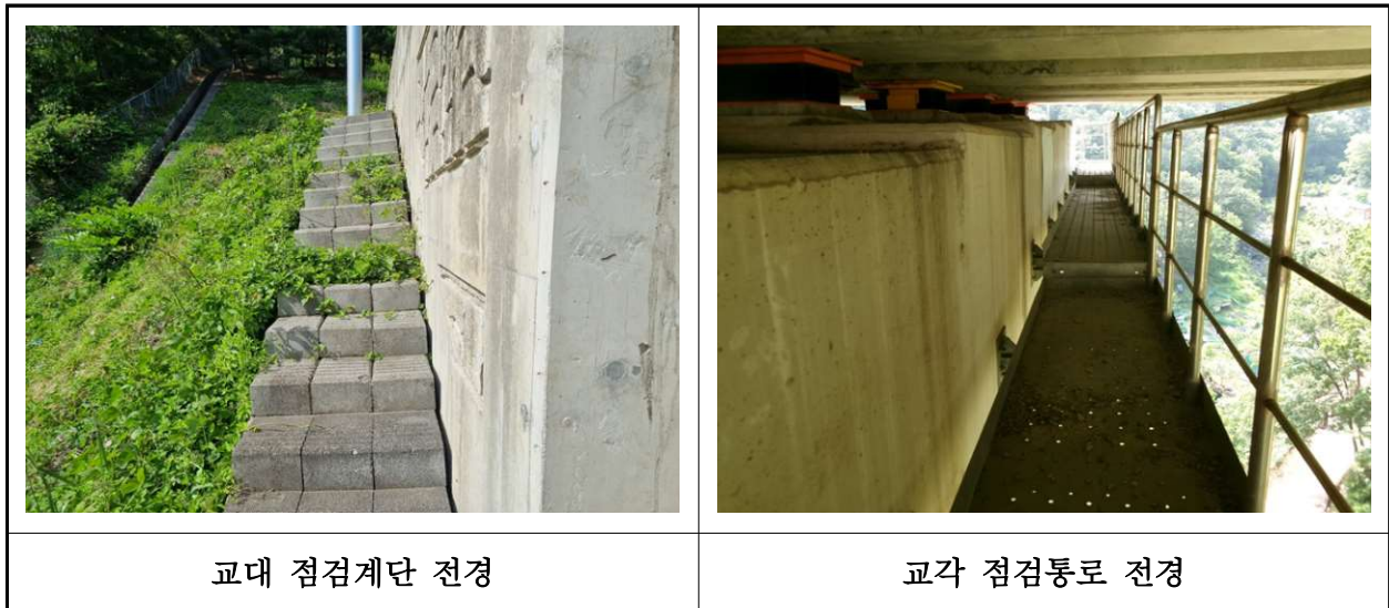
【사진 27.3.26】 교량 점검시설 전경
