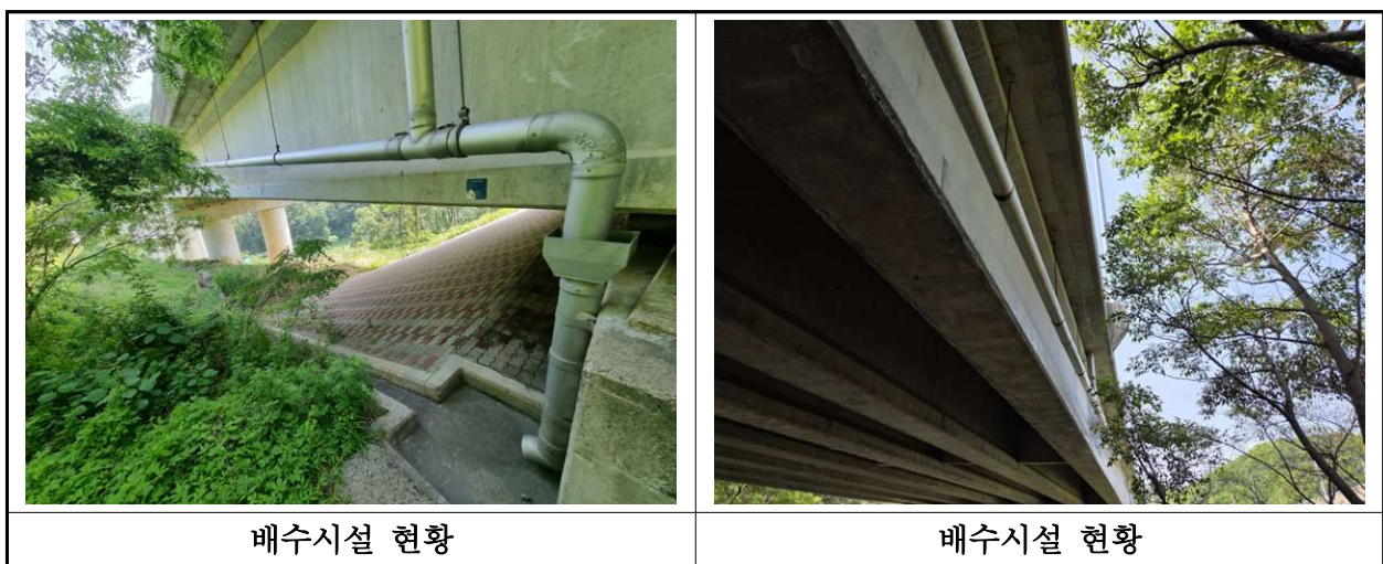
【사진 27.3.22】 배수시설 전경
